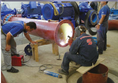
Изградња пумпне станице Штранд, донатор KfW
